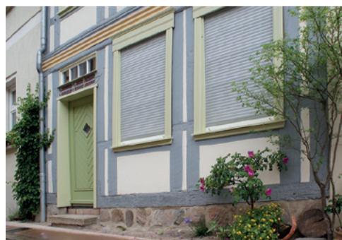
Salzstraße 14 Die Grundschwelle liegt auf einem hohen Feld-steinsockel. Das schützt das Holz vor Spritz-wasser.
