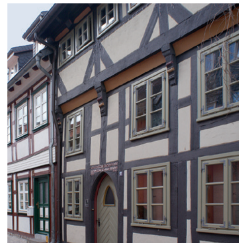
Kramstraße 10 Das von 1998 bis 2001 sanierte, dreigeschossige Fachwerkhäuser ist von der ARGE Historische Fachwerkstädte mit einer Anerkennungs-urkunde ausgezeichnet worden.
