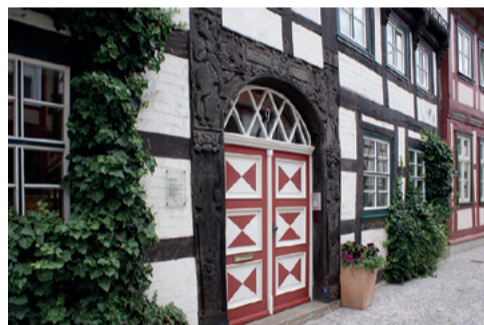
Radestraße 9 Die eindrucksvolle Renaissance-Fassade aus dem Jahr 1596 (1992 saniert) ziert das so genannte Rit-terhaus. Das Einzeldenkmal erhielt seinen Namen aufgrund der im Eingangportal dargestellten zwei geharnischten Ritter.
