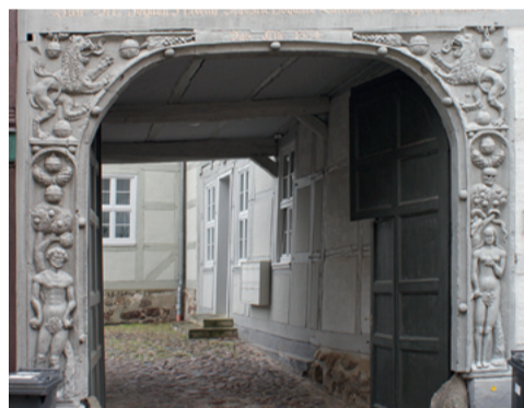
Schmiedestraße 27 Das Adam- und Eva-Tor ist eines der bekanntesten Salzwedeler Bauwerke. Das Portal stammt aus dem Jahr 1534 und gehörte eigentlich zu einem mit Schnitzereien verzierten Haus. Beim Nachfolgebau ist das Tor 1840 wieder verwendet worden. 2003 wurde das Gebäude saniert.
