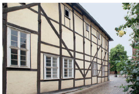
Schmiedestraße 30 Das Hochständerhaus gehört zu den ältesten Salzwedeler Fachwerkhäusern. Es stammt aus dem 15. Jahrhundert. Deutlich zu erkennen: die von der Grundschwelle bis zum Rähm unters Dach wirklich durchgehenden Ständer. Die an ihnen befestigten Deckenbalken ragen aus der Fassade heraus.
