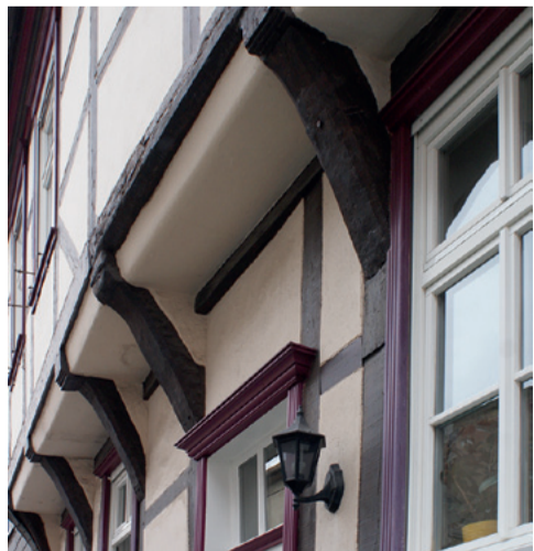
Jenny-Marx-Straße 13 - 15 Abgaben richteten sich einst nach der bebauten Grundstücksfläche. Deshalb ragen obere Etagen oft über das Erdgeschoss hinaus. So sparte man bares Geld.
