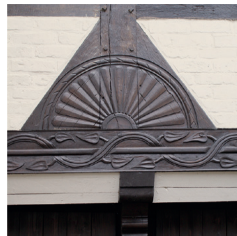
Burgstraße 18 Im historischen Bürgermeisterhof findet man neben Hochständerfachwerk auch Fußwinkel-hölzer, so genannte Palmetten.
